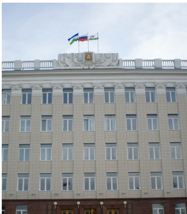
Пример протокольного оформления фасада здания
